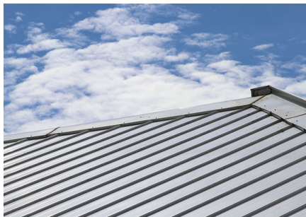
ภาพที่ 1.4 หลังคาเหล็กเมทัลชีท
